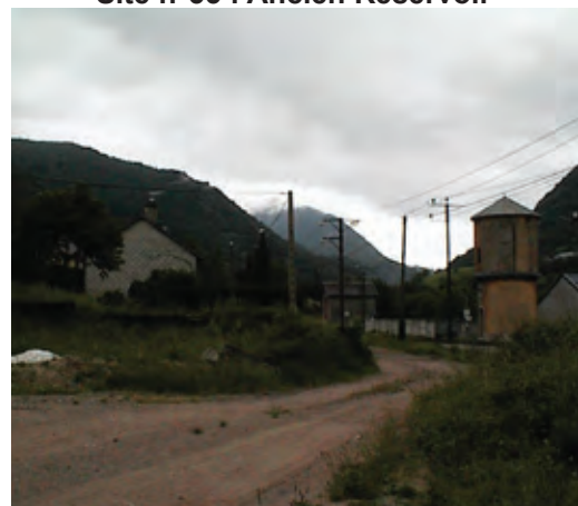
Site n°55 : Ancien Réservoir
