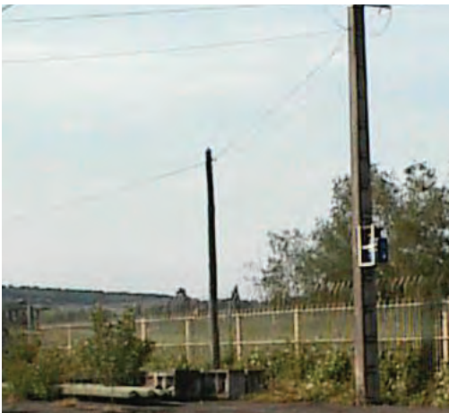
Site n°3 : RN 117, entreprise Gury
