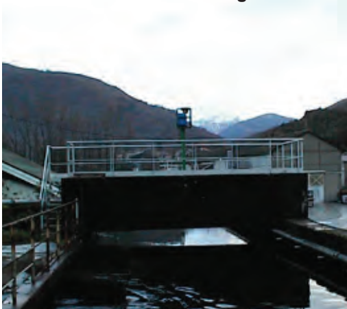
Site n° 17 : Ancien dégrilleur
