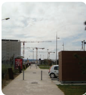
Installée côté parc de stationnement depuis le 3 juin 2006
