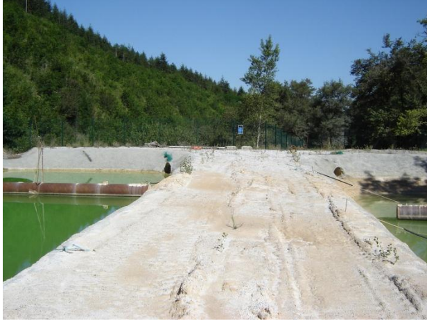
Site n°98 : Bassin de rétention
