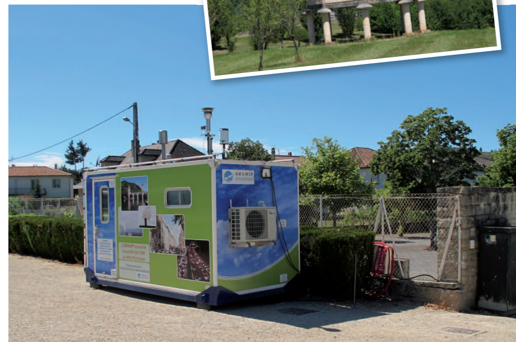
Station de qualité de l'air à Cahors, près du complexe sportif Pierre Ilbert. Cette station surveille la qualité de l'air ambiant dit "de fond" de la ville. Elle mesure des principaux indicateurs de pollution atmosphérique : ozone, dioxyde d'azote et particules en suspension inférieures à 10 microns. Les mesures relevées par l'ORAMIP sont diffusées en continu sur www.oramip.org
