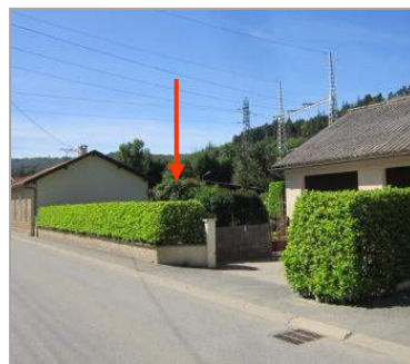
Nouvel emplacement du point « Avenue Mesones »
