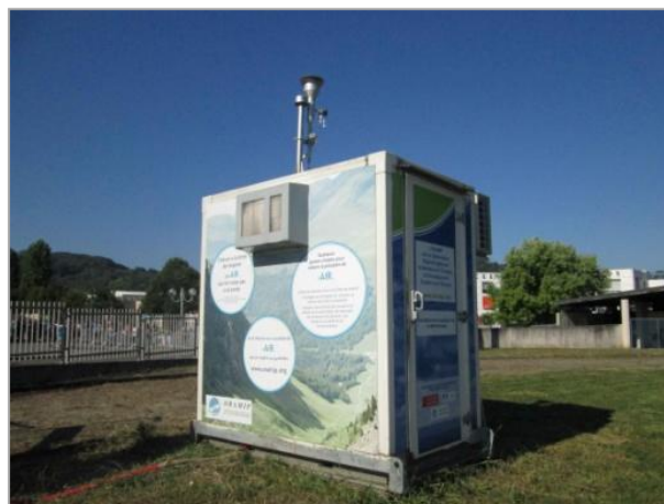
Station de mesure de qualité de l'air - Pamiers
