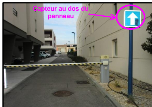
Site n°3 : Entrée d'un parking résidentiel le long de l'avenue Monteroni d'Arbia
