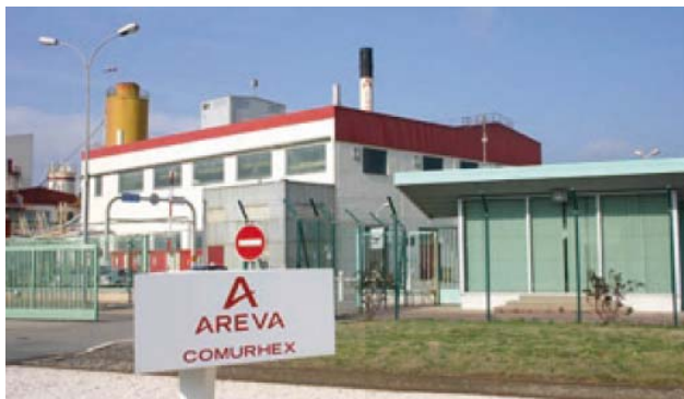
Entrée de l'usine
