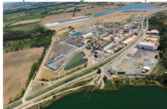
Vue aérienne (COMURHEX à gauche de la route)
