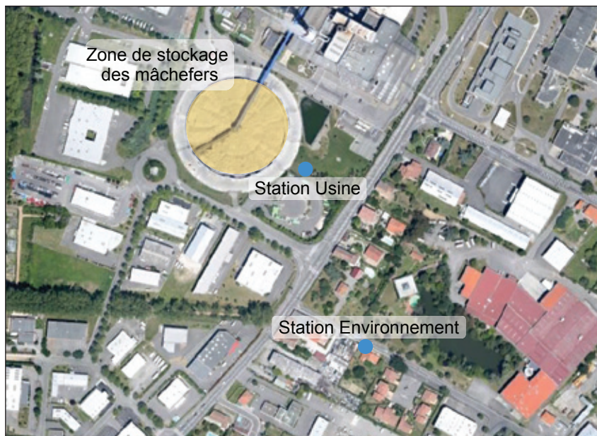
Vue aérienne de la zone de stockage des mâchefers -Site Usine
