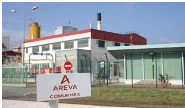
Entrée de l'usine
