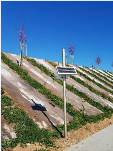
MC4 Merlon – Proximité voies
