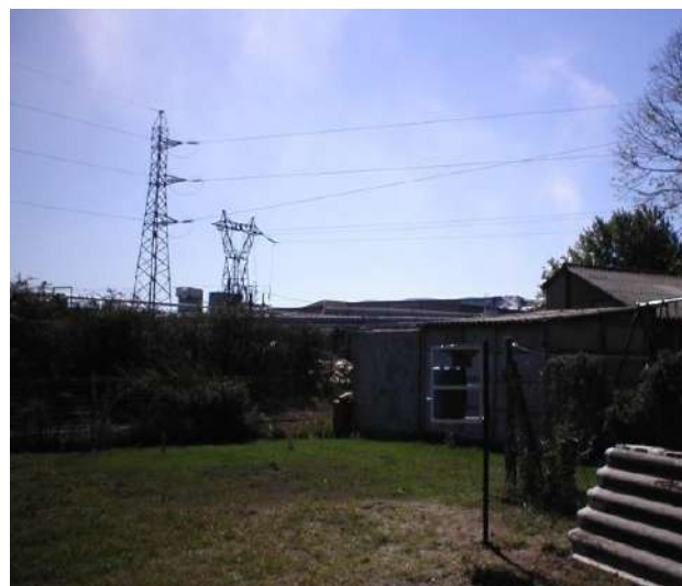
Site ex n° 67 : Chemin de l'Emprunt
