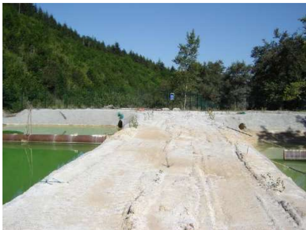
Site n°98 : Bassin de rétention
