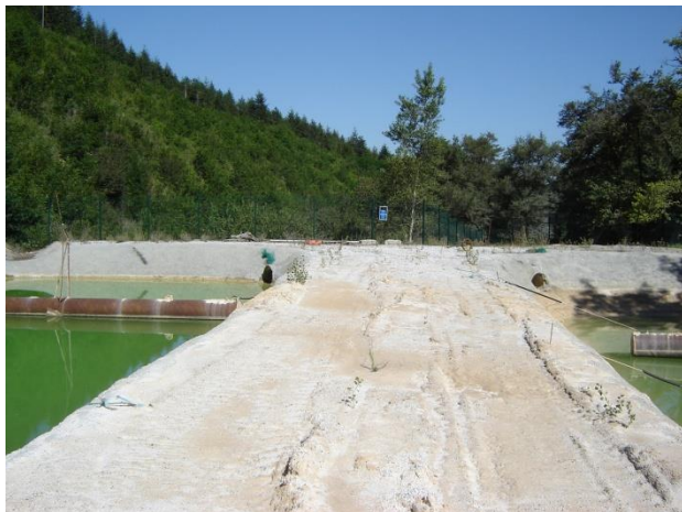
Site n° 98 : Bassin de rétention
