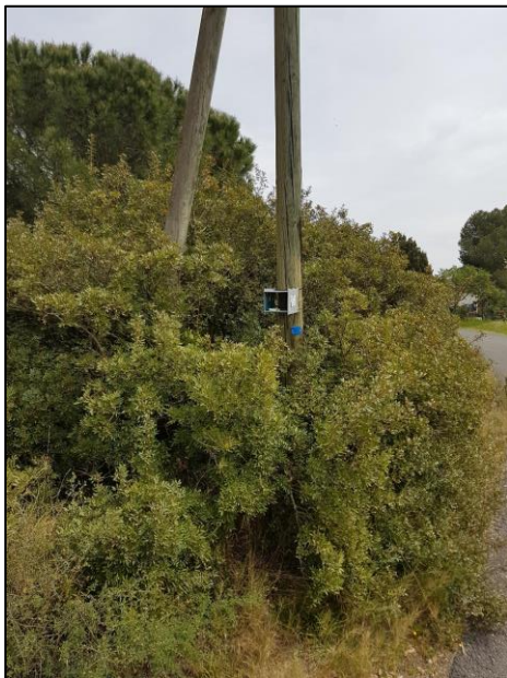
Site n°2 Chemin Rural 61
