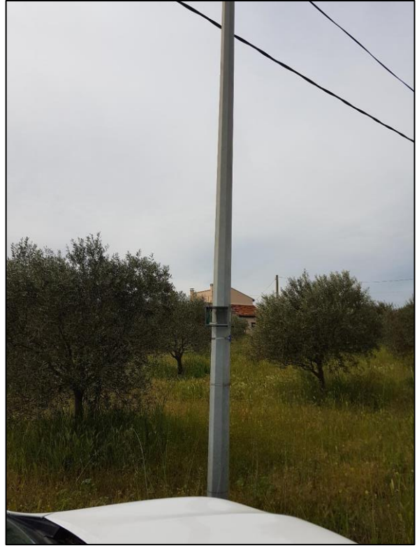
Site n°9 Chemin Rural 55
