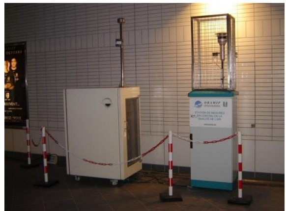
Photo 1 : Station de mesure provisoire sur le quai d'une station de métro
