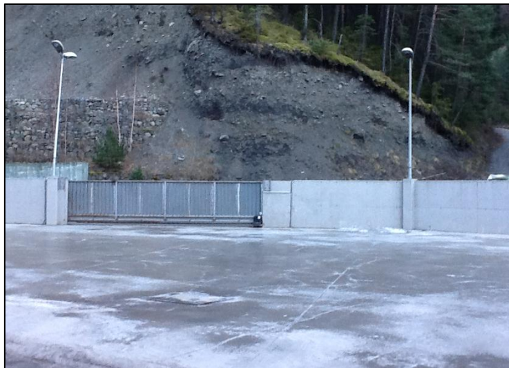
- foto 1 : porta corredora amb la placa col·locada -
