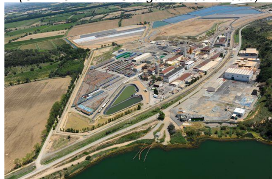
Vue aérienne (ORANO MALVÉSI à gauche de la route)
