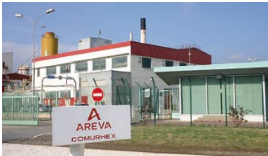
Entrée de l'usine
