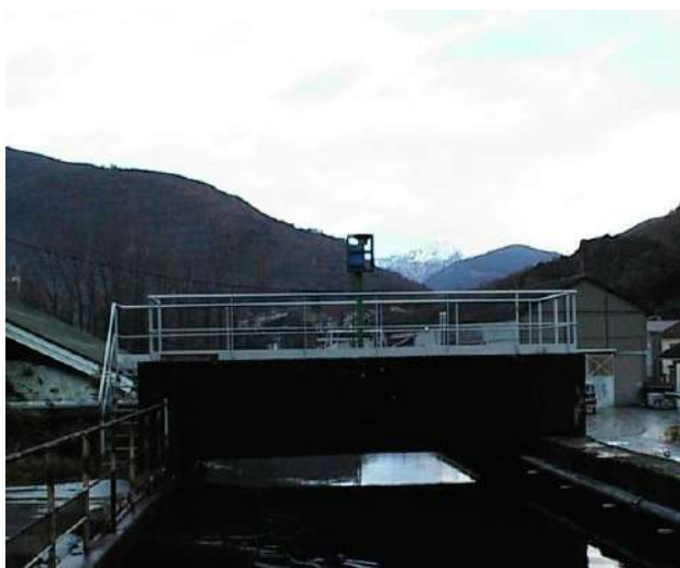
Site n°17 : Ancien Dégrilleur
