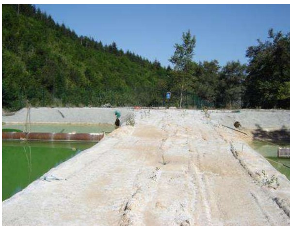
Site n°98 : Bassin de rétention
