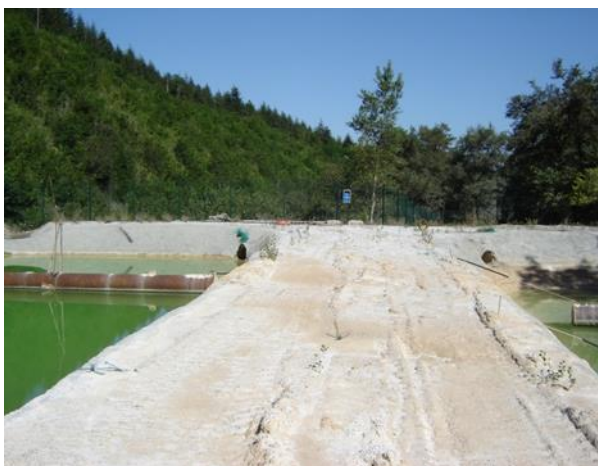
Site n°98 : Bassin de rétention
