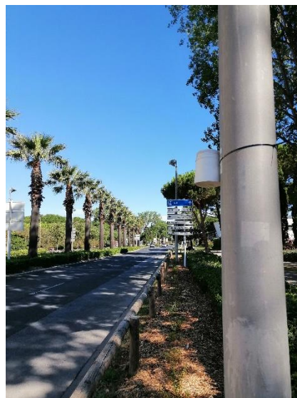
Site 2102 – La Grande Motte – Avenue de Montpellier – Devant Palais des Congrès
