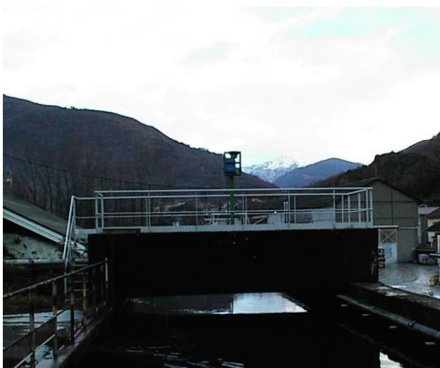
Site n°17 : Ancien Dégrilleur
