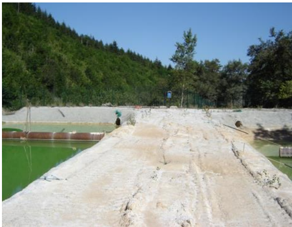
Site n°98 : Bassin de rétention
