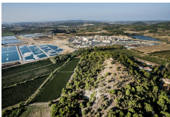
Figure 1 : Site d'ORANO-CE Malvési à Narbonne
